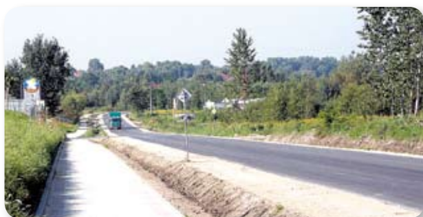
647 109,92 zł – remont ulicy Zakładowej
