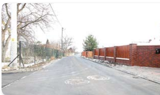
2 758 215,36 zł – remont dróg uszkodzonych w wyniku ulewnych deszczy na osiedlu Miechocin, Sielec i Zakrzów
