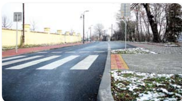
374 804,41 – przebudowa drogi powiatowej – ul. Sandomierska
