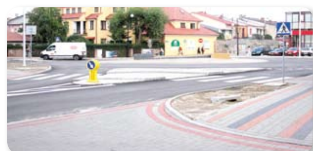
8 434 197,82 zł – w 2011 roku zakończyła się modernizacja ul. Targowej z rondem w ul. Piłsudskiego i ul. Szerokiej z ul. Szpitalną wraz ze skrzyżowaniem z ul. Mickiewicza w postaci rodną
