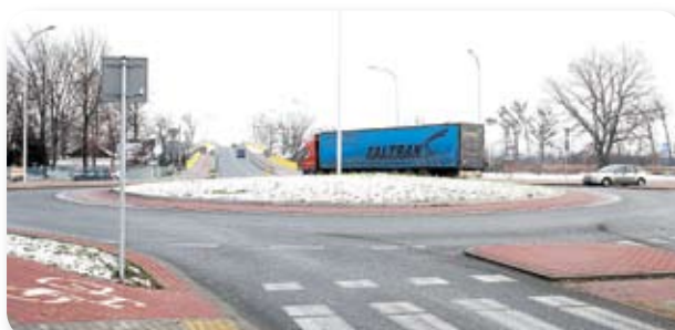
59 159 176,90 zł – modernizacja drogi wojewódzkiej nr 871 wraz z budową wiaduktu nad torami
