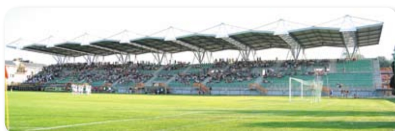
Przebudowa stadionu miejskiego – kolejny etap: 5 156 000 zł
