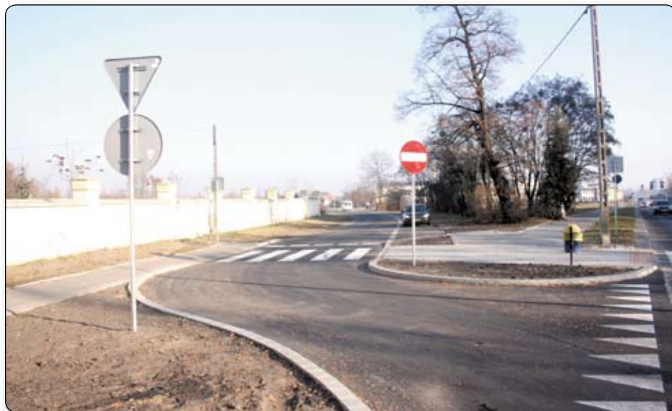
W ciągu najbliższych dni zostanie ogłoszony przetarg na drugi etap prac przy przebudowie ulicy Sandomierskiej.
