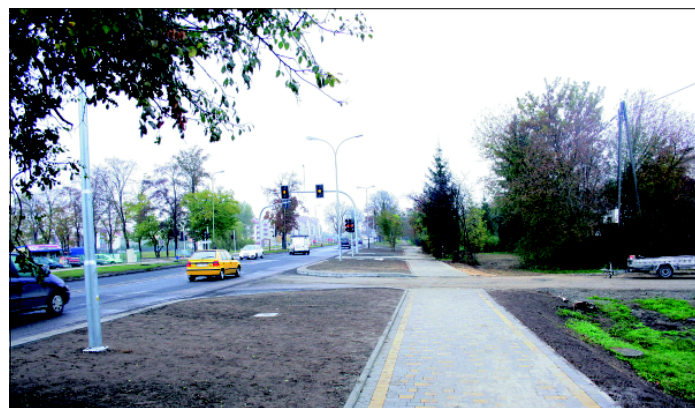
Remont skrzyżowania ul. Sikorskiego-Wiejska powinien zakończyć się do końca listopada br.
