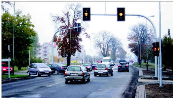
Drogowcy muszą jeszcze położyć nową nawierzchnię oraz zrobić oznakowanie.
